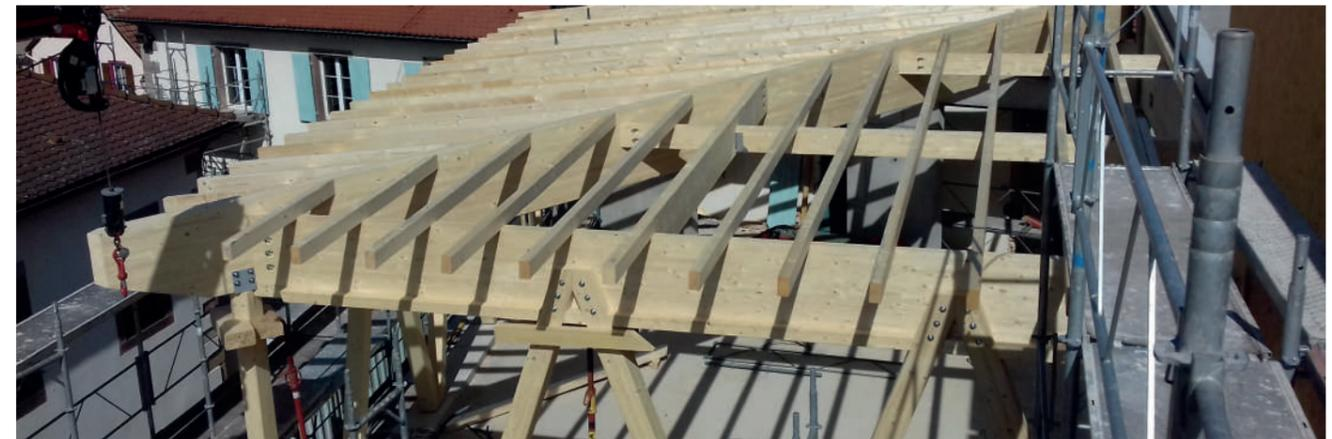
Élévation de la structure bois de l'extension et assemblage de la charpente.
