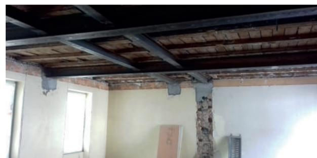
Renforcement structurel à l'aide de poutres métalliques.
