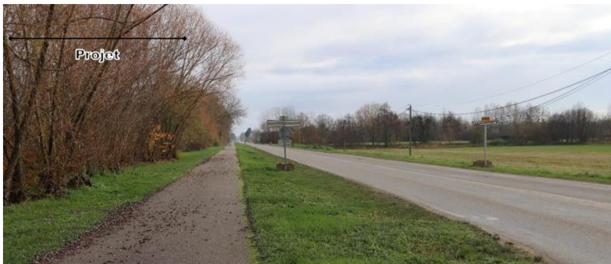
Photo 3. Vue depuis la sortie est de Krautergersheim à l'ouest du projet – Source : GÉNÉRALE DU SOLAIRE
